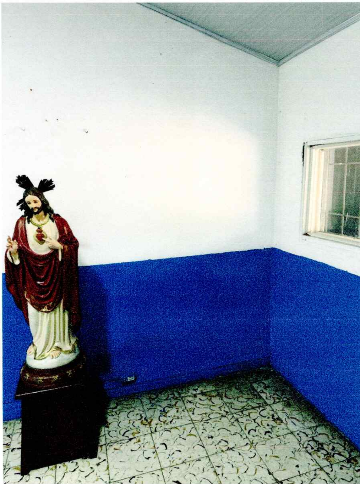
Fotografía 6. Inspección visual de muros, cielorraso y vano de ventana.
