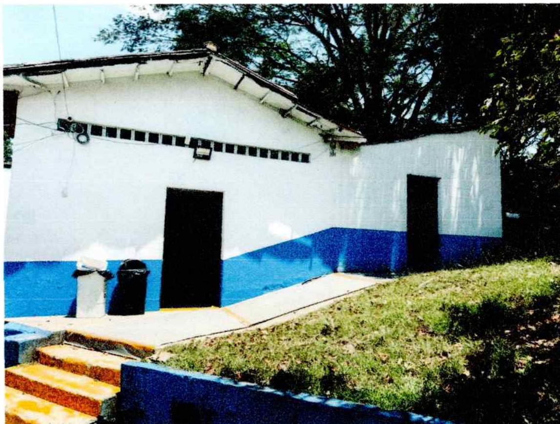
Fotografía 1. Vista general exterior de uno de los bloques de la institución.
