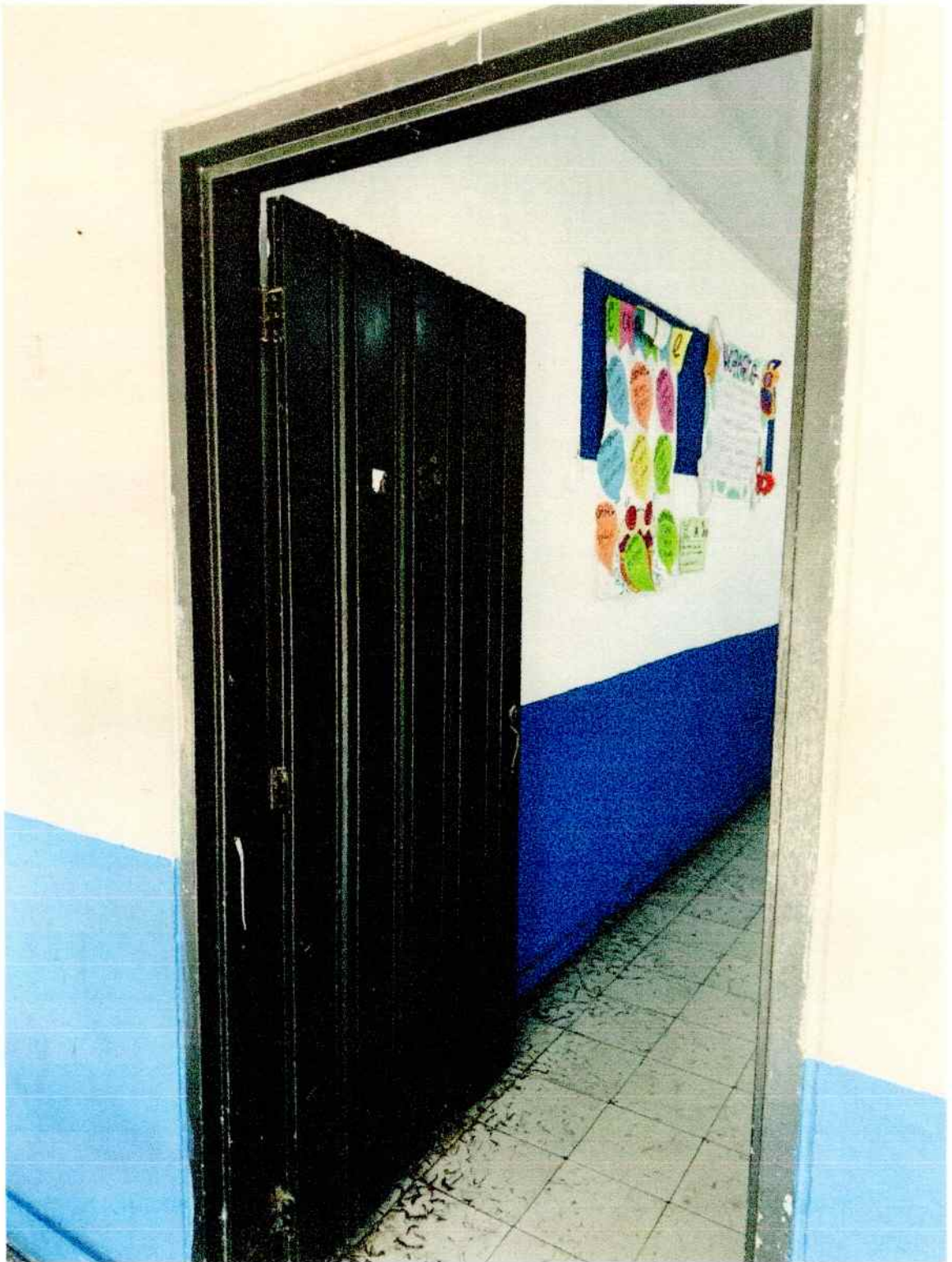
Fotografía 7. Acceso y condición general de elementos no estructurales.
