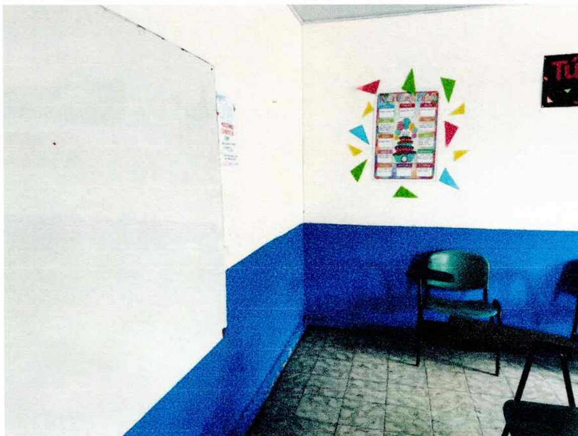
Fotografía 3. Condición general de muros y cielorraso en aula.
