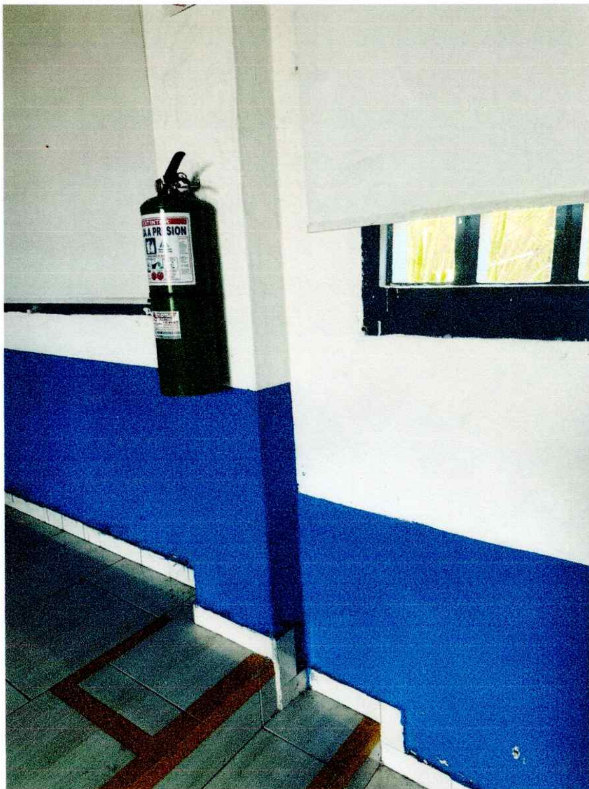
Fotografía 9. Inspección de muro y elemento vertical en zona de circulación.
